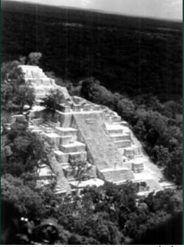
FOTO: Vista aérea de la Estructura II en Calakmul. CRD: Dirección de Operación de Sitios. F. Manuel Zavala.
