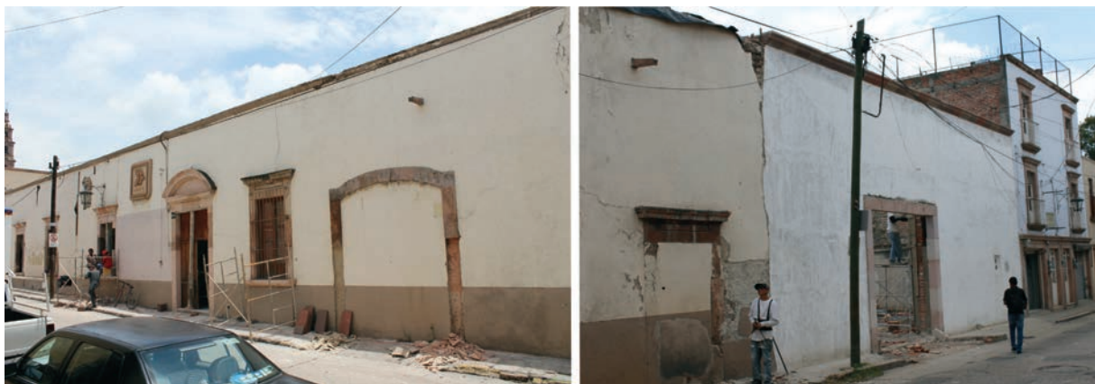
Imagen 2. Banco Rural de Lagos de Moreno, 2015, proceso de demolición interna. Archivo de la autora.
