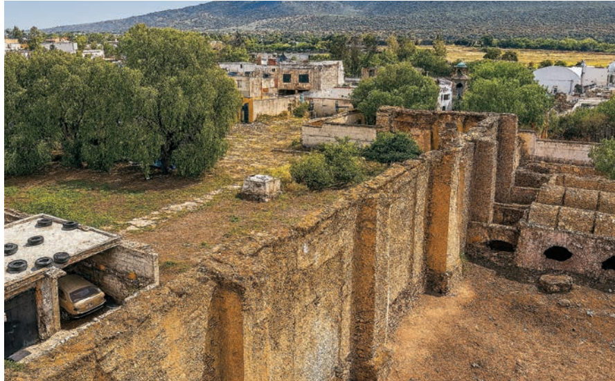
Imagen 5. Cimientos de la barda perimetral. Fotografía: Roberto Carrillo Acosta, noviembre de 2023.
