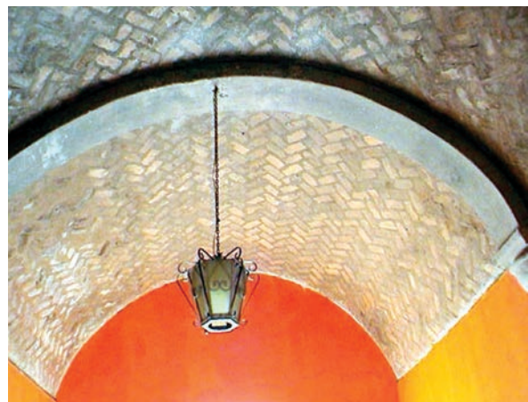
Imagen 9. Casa del Hacendado, detalle constructivo. Fotografía: Oda Jadi Lamas Vázquez, 2023.
