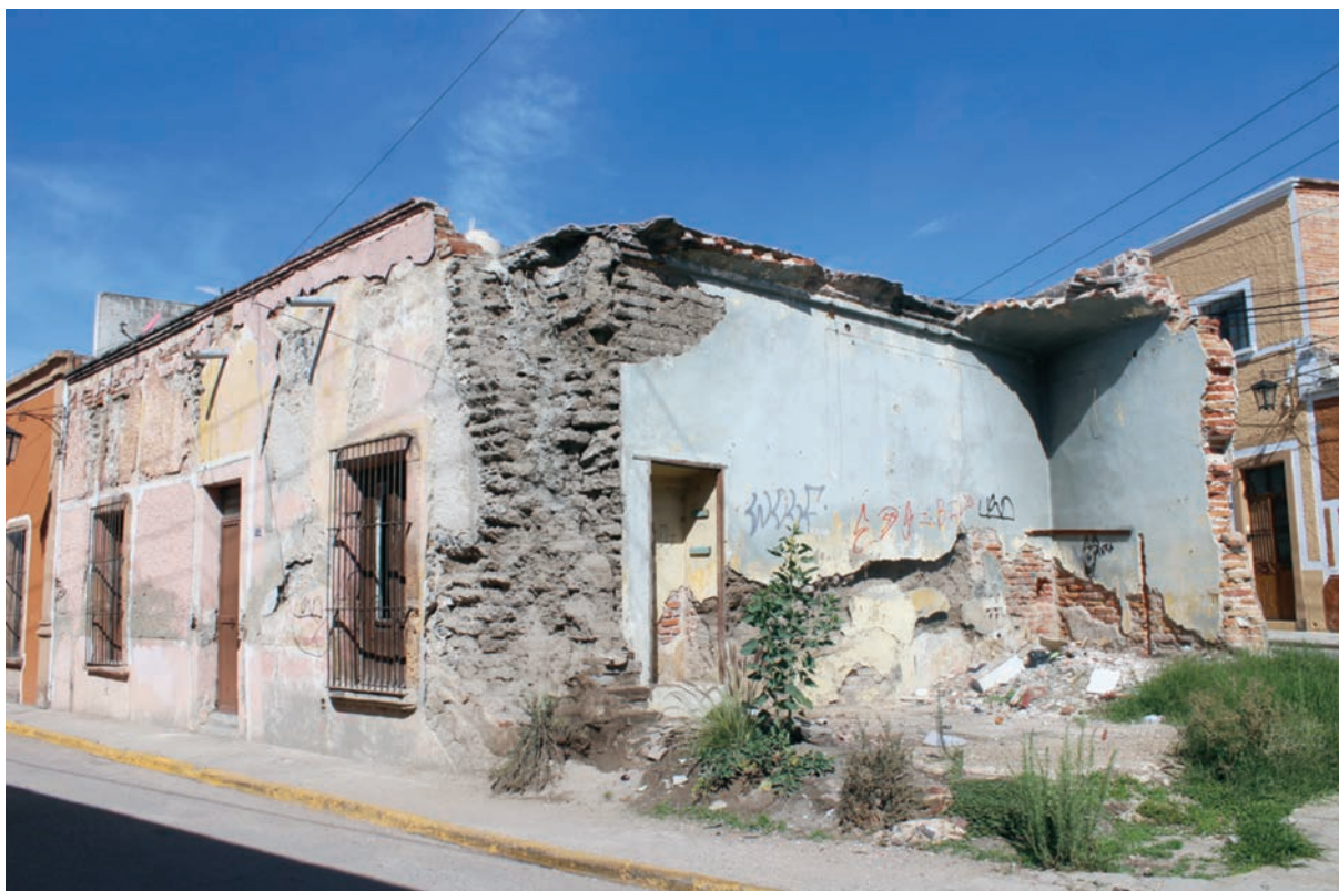
Imagen 4. Finca en proceso de demolición, no catalogada como monumento histórico / Valor Artístico Relevante, 2022. Archivo de la autora.
