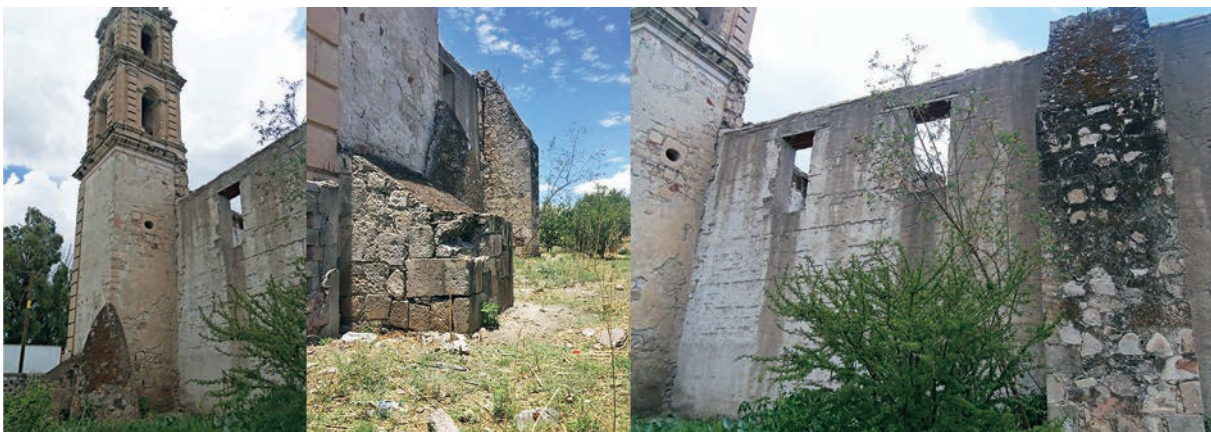
Imagen 8. Las soluciones estructurales de la capilla. Fotografía: A. Migali Izaskun Esparza Aldaba.
