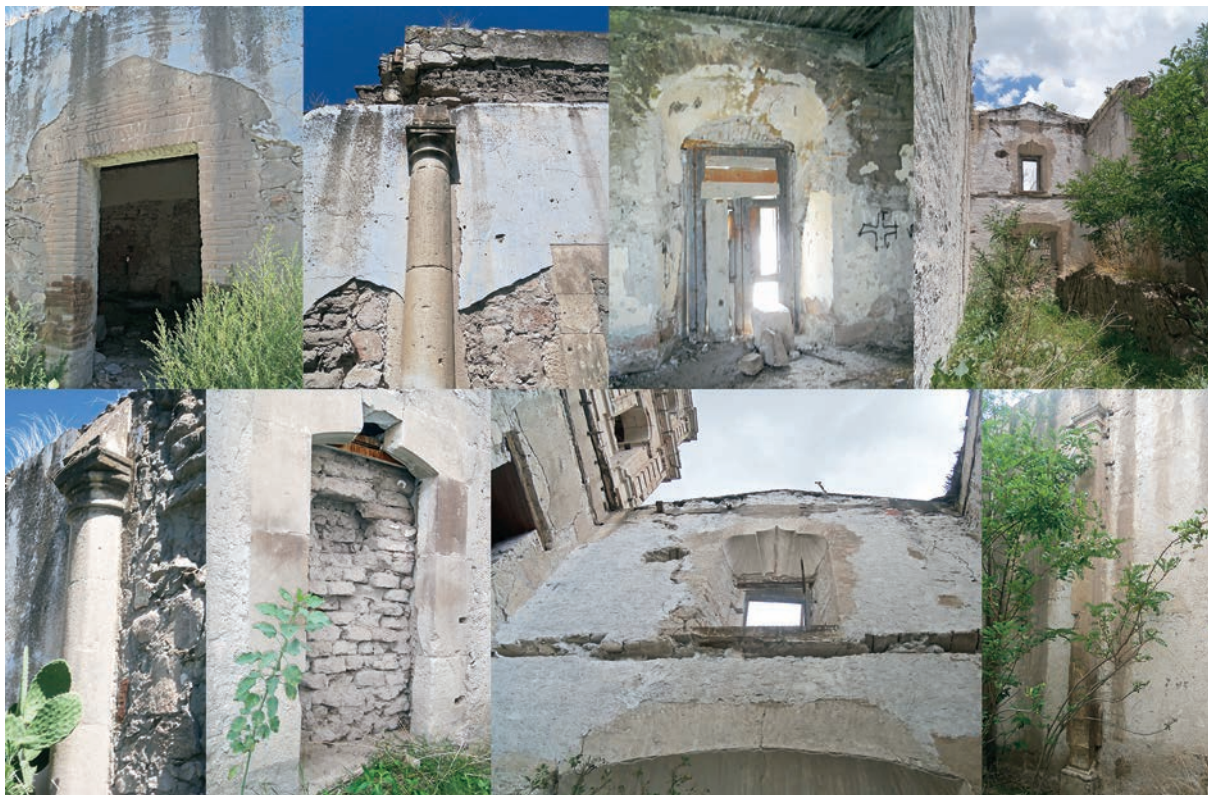
Imagen 5. Vestigios de los elementos arquitectónicos tanto exteriores como interiores de la casa y la capilla. Fotografía: A. Migali Izaskun Esparza Aldaba.
