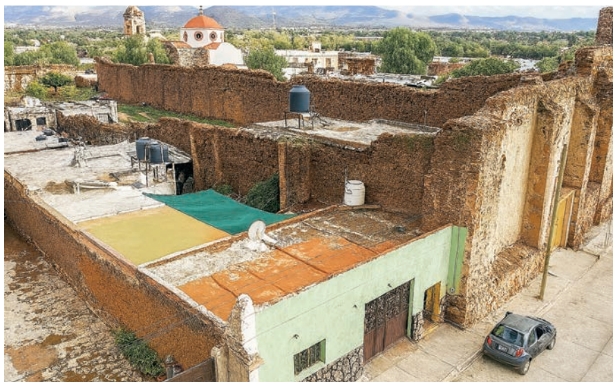
Imagen 3. Vista superior del Fuerte de Malpaso. Estructura rectangular. Fotografía: Roberto Carrillo Acosta, noviembre de 2023.
